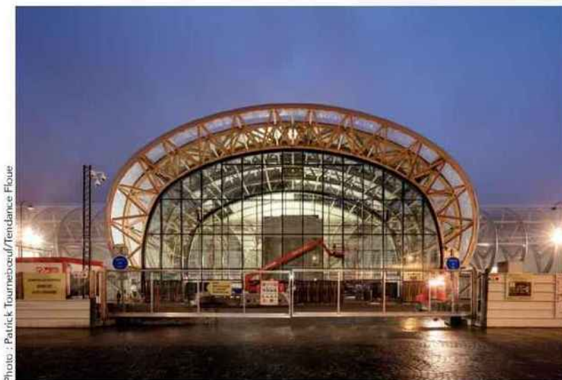
▲ La structure du Grand Palais Éphémère est réalisée avec trois essences certifiées PEFC : l'épicéa, le Douglas et le mélèze (maître d'ouvrage : Réunion des musées nationaux-Grand Palais ; architecte : Wilmotte & Associés ; entreprise : Mathis).
